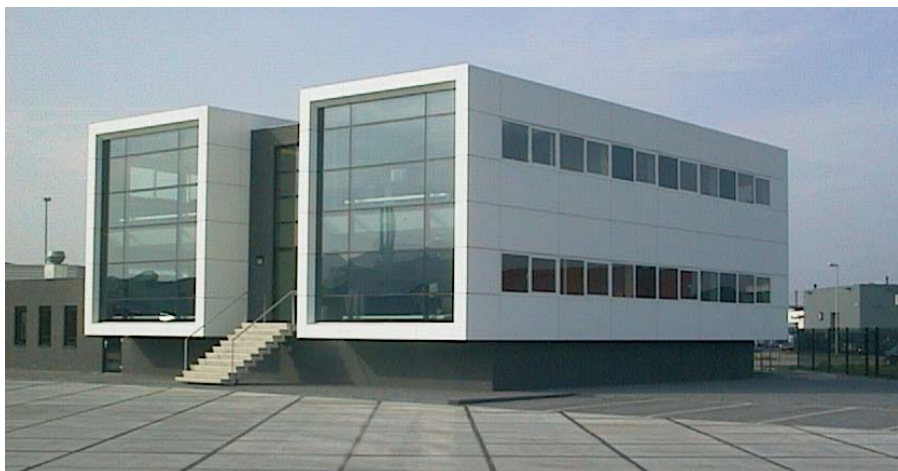
Het hoofdkantoor van Winder Limmen in Alkmaar.
